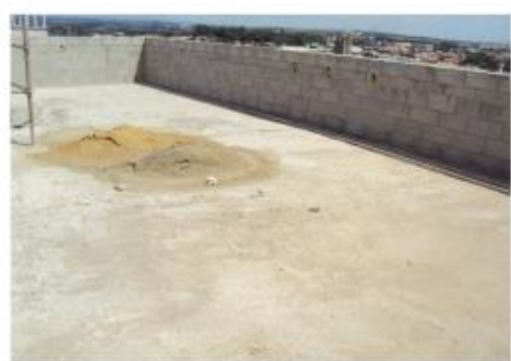
VISTA DA COBERTURA E ALVENARIA NAS PLATIBANDAS
