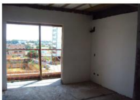
SEQUENCIA DOS TRABALHOS DE REVESTIMENTO EM GESSO EM PAREDES
